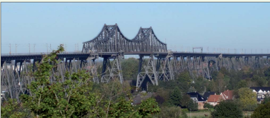
Die Rendsburger Kanalbrücke.
