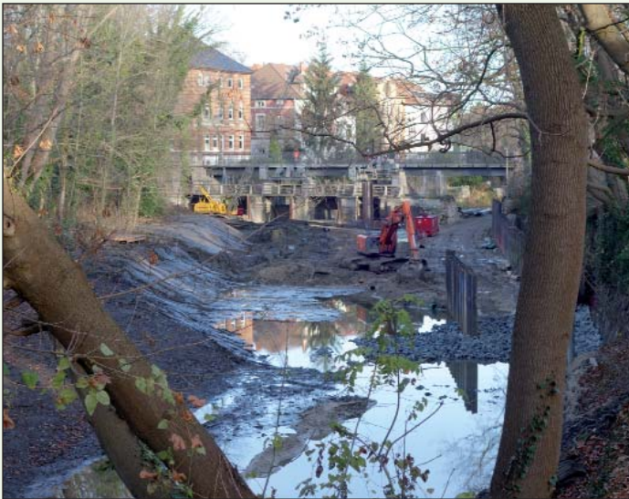
Niedriger Wasserstand Richtung Baustelle.
