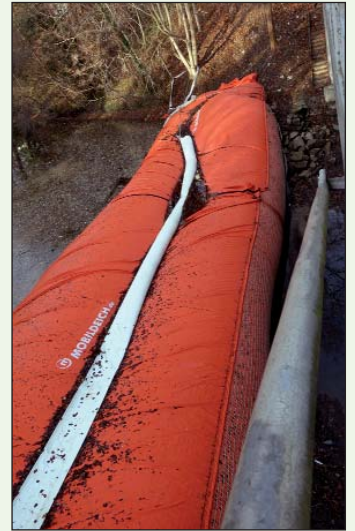
Der „Mobile Deich“ an der Celler Straße zum Trockenlegen der Oker im Bauabschnitt.
