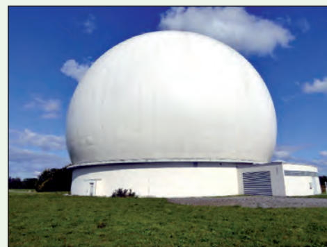
Hülle der Parabolantenne.
