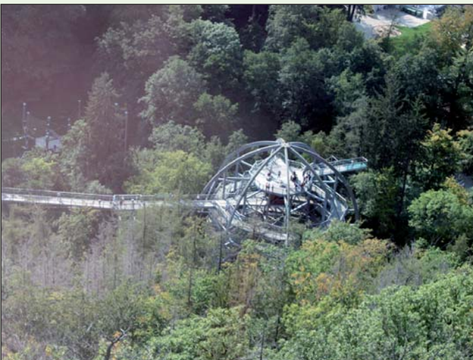
Der Eingang des Baumwipfelfades in Bad Harzburg. Von hier aus kann man etwa 1.000 m über den Bäumen entlanggehen.
