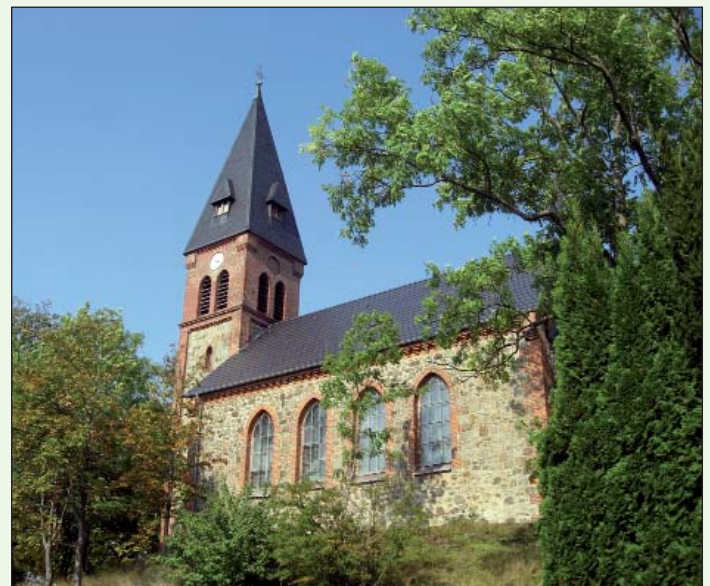
Bonhoeffer Kirche in Friedrichsbrunn. Foto: B. Kleszczewski
